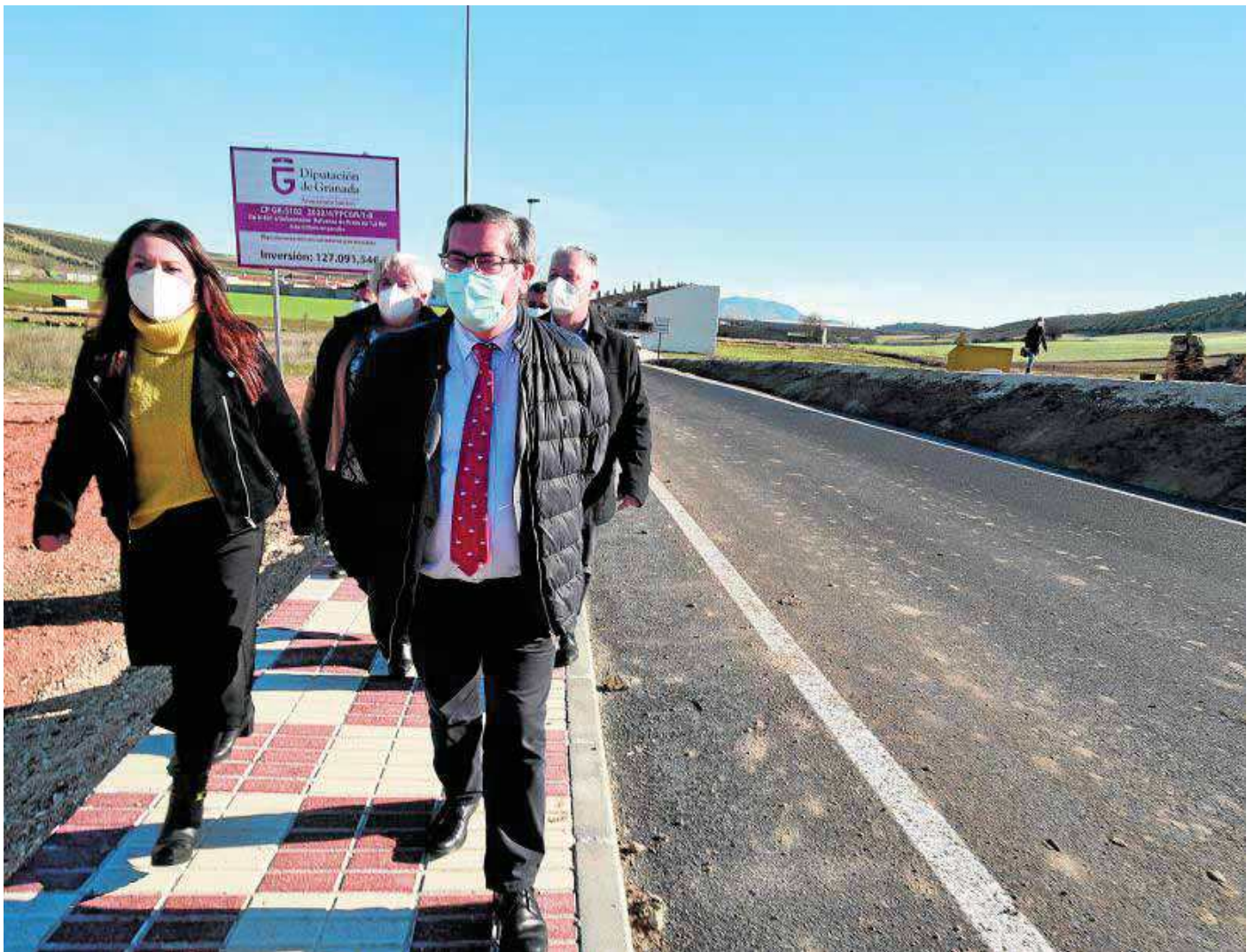
El presidente de la Diputación de Granada ha visitado las obras de las tres carreteras provinciales (en la foto, en Gobernador). R. MARTÍNEZ /DIPGRA
