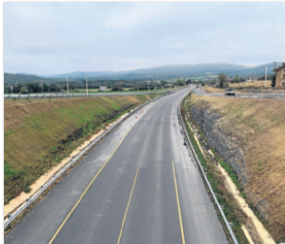
Las obras de la N-240 está previsto que concluyan antes de que finalice este año.
